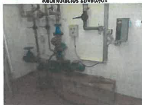
Izopvítelő szivattyú frekvenciaváltóval
