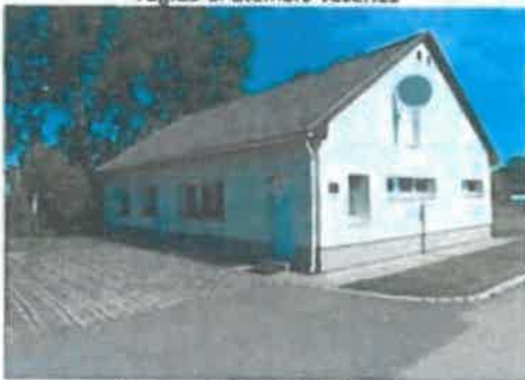
Szennyvíztelep kezelő épület
