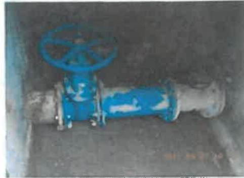
Bartók B. úti mérőakna gépészet
